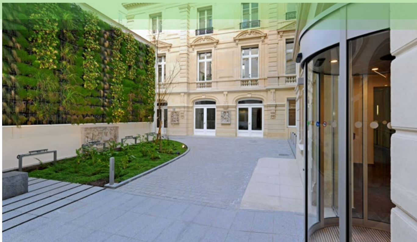
Immeuble rue de la Boétie - Paris 8 ème
