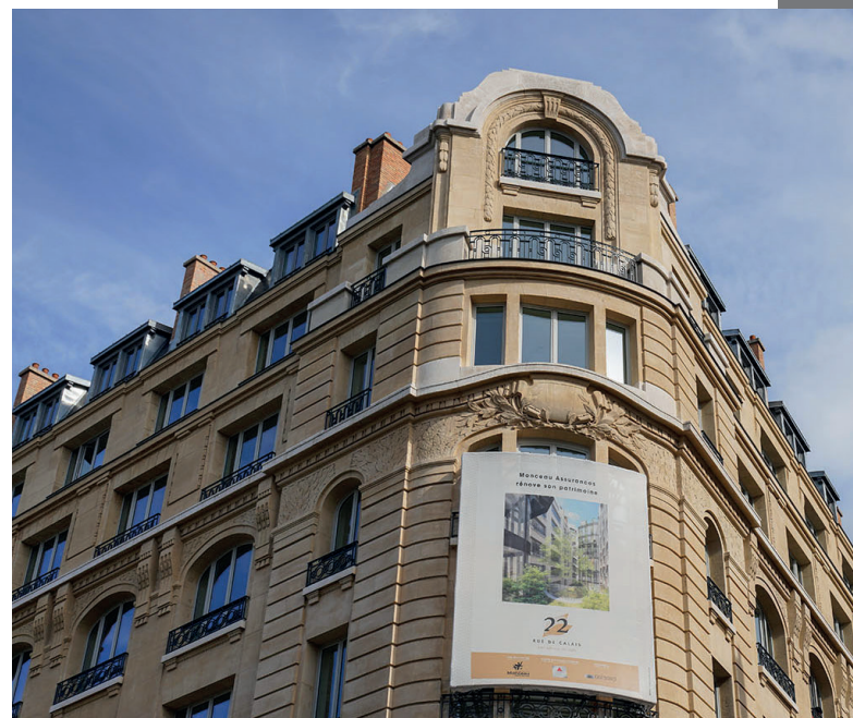
➤ Immeuble situé rue de Calais (Paris) entièrement rénové en 2019
